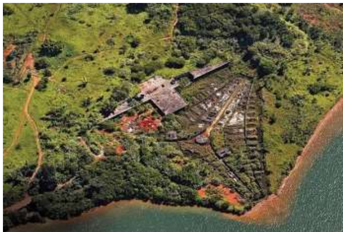
Figura 1: Sergio Bernardes, ESG, DF, 1970/74. Imagem “Ruínas da UNB”, estruturas de concreto remanescentes da obra abandonada (2014). Fonte: http://vejabrasilia.abril.com.br/materia/cidade/os-segredos-dos-escombros Acesso em: 24/03/2016.
