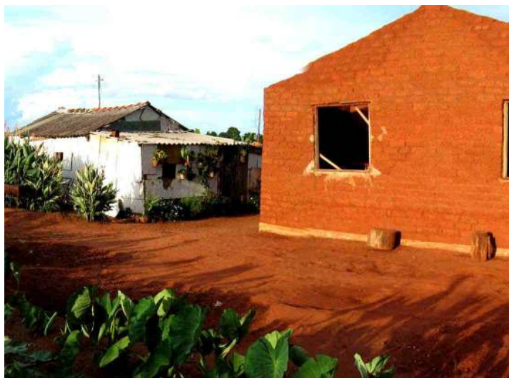
Figura 2: À esquerda os antigos barracões de madeira e à direita as novas casas de adobe. Fonte: < http://www.usp.br/agen/repgs/2004/pags/124.htm >.
