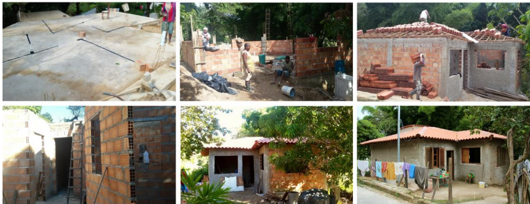
Figura 4: Fases da obra.
