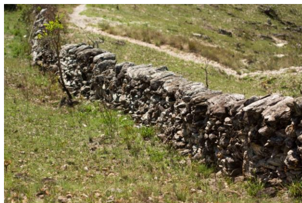
Figura 11: Muro de Pedra, na Serra do Lenheiro. 2016.
