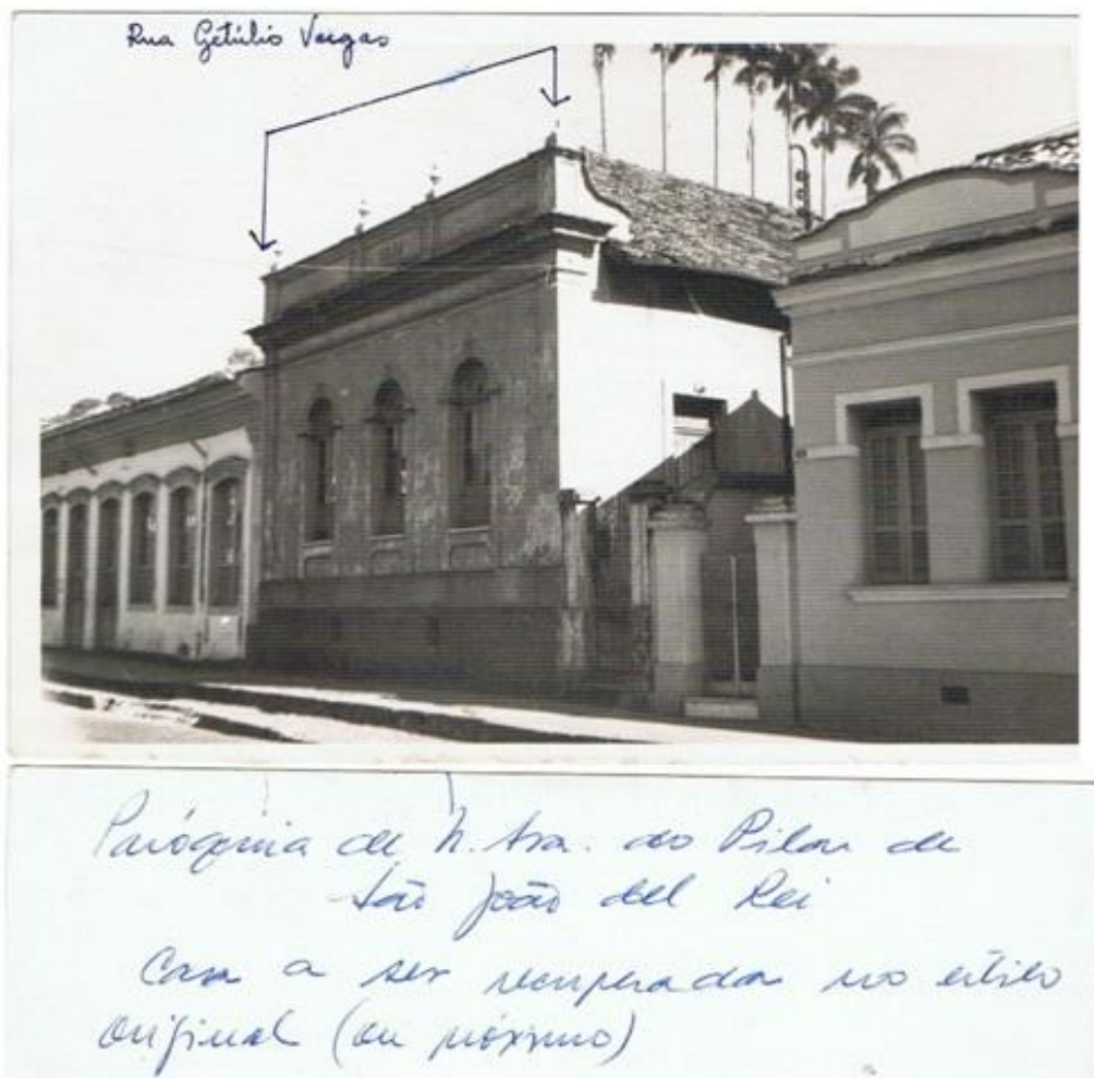
Figura 1: Foto da edificação nº 3, ao centro, na década de 1960, com grifo em caneta feito por funcionário do IPHAN, e seu verso, onde está escrito: "Paróquia de N. Sra. do Pilar de São João del Rei. Casa a ser recuperada no estilo original (ou próximo)".
